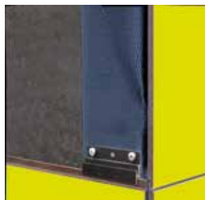
Open voeg in de hoek met EPDM-voegband
